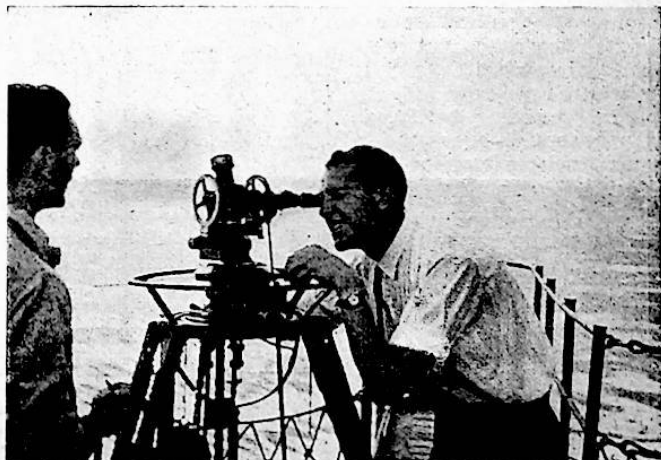
Bij goed zicht wordt de pilot ballon gevolgd met een theodoliet, wat goedkoper uitkomt dan gebruik van radar
